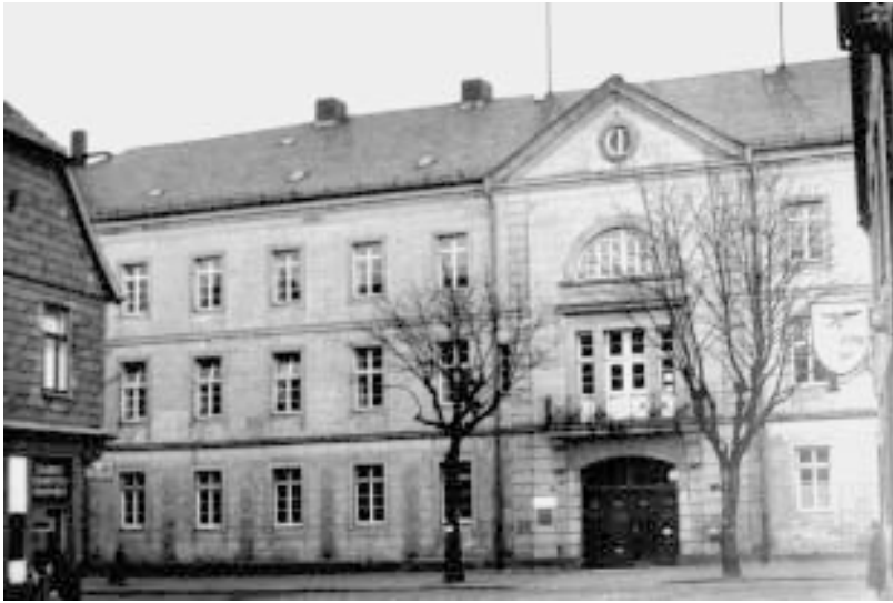
Kaserne Leopold- straße (1830), Ansicht von Exterstraße vor dem Abbruch 1967.
